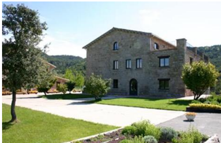
Figura 6. Instalaciones del CEDRICAT en Solsona
