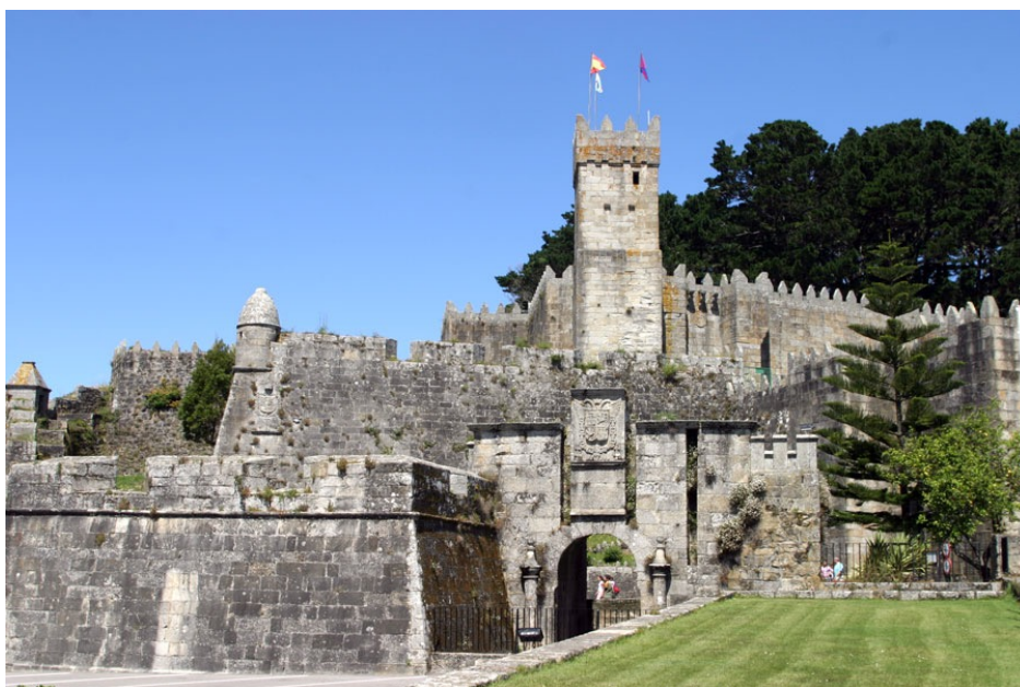
Castelo de Monterreal e Fortaleza
